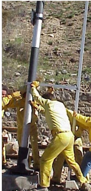
Figura 12. Montaje de mastil de señal
