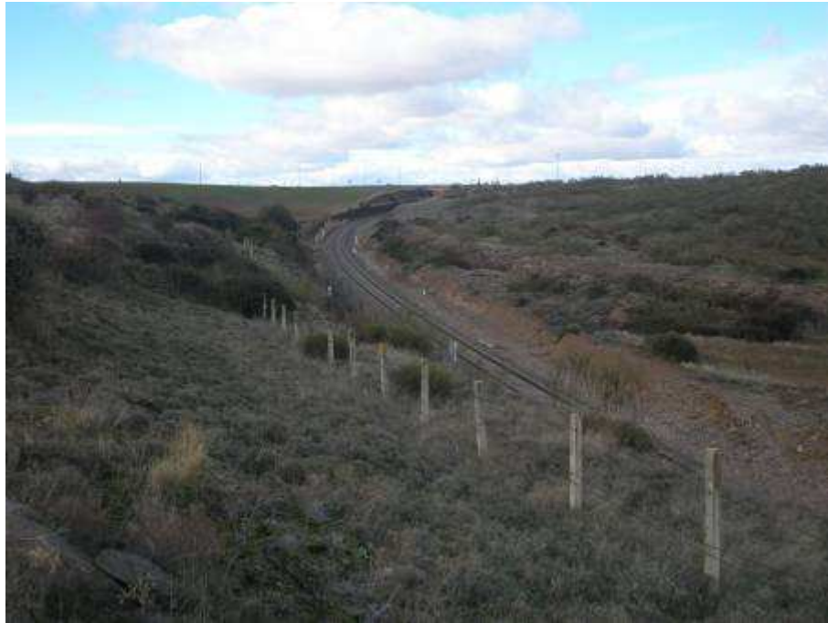
Vista zona ubicación del paso bajo la N-620 al fondo.
