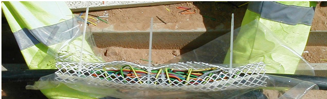
Figura 31. Empalme de cuadrete
