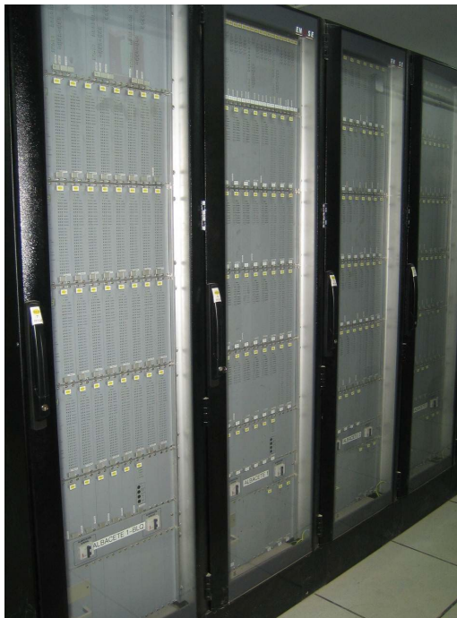
Figura 1. Módulos de enclavamiento EIS23
