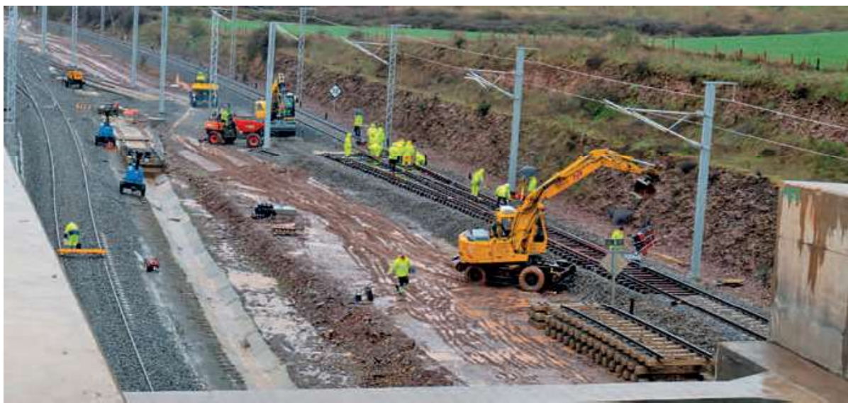
Imagen de la ejecución del denominado ‘pinchazo’ ferroviario que permite conectar las vías internas del puerto seco con la línea férrea Salamanca-Fuentes de Oñoro.
